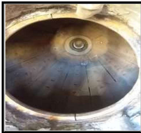
MONTAJE DE FORROS MOLINO 4' X 8' U.M CIEMSA
